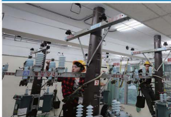
室內配線技能檢定考場
