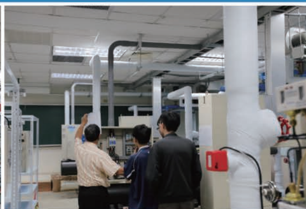
冷凍空調裝修技能檢定考場
