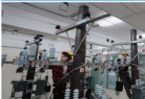
室內配線技能檢定考場
